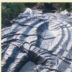
высокой эластичности пленки, ее легче укладывать. Затем пленка прижимается к основанию, например камнями или специальным субстратом. При этом желателен слой защитной пленки с наружной стороны слоем геотекстиля. На берегу пленка сначала должна выступать на несколько сантиметров в вертикальном положении, так как она после заполнения пруда водой может еще осесть. Лишь через несколько дней излишки пленки можно обрезать.
