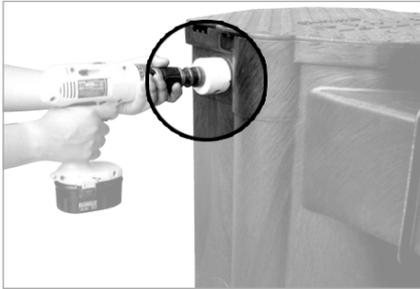
С помощью фрезы вырезается необходимое отверстие для подключения шланга 50 мм [60], 40 мм [48], 25 мм [33].
